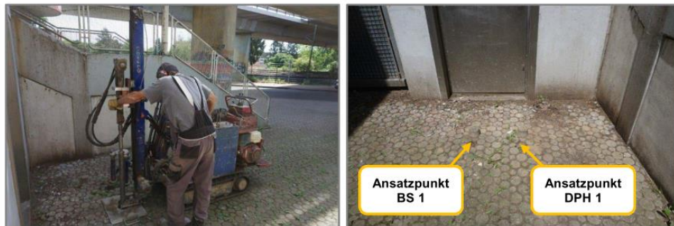
Abbildung 5: Durchführung der Bohrsondierung BS 1
