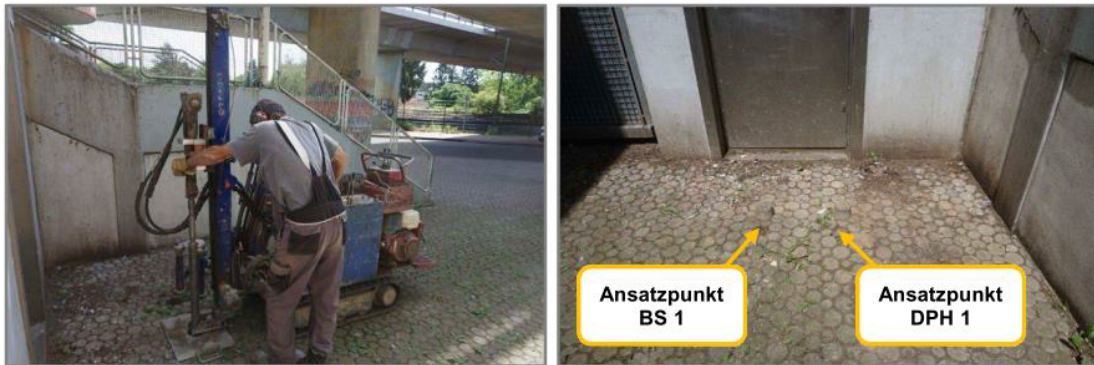
Abbildung 5: Durchführung der Bohrsondierung BS 1
